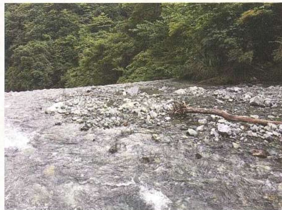
自動車が転落した箇所から200メートル先の堰堤
